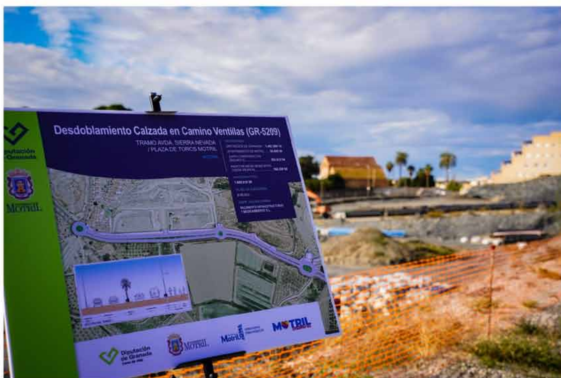
Panel informativo con los detalles de la obra (EL FARO)
