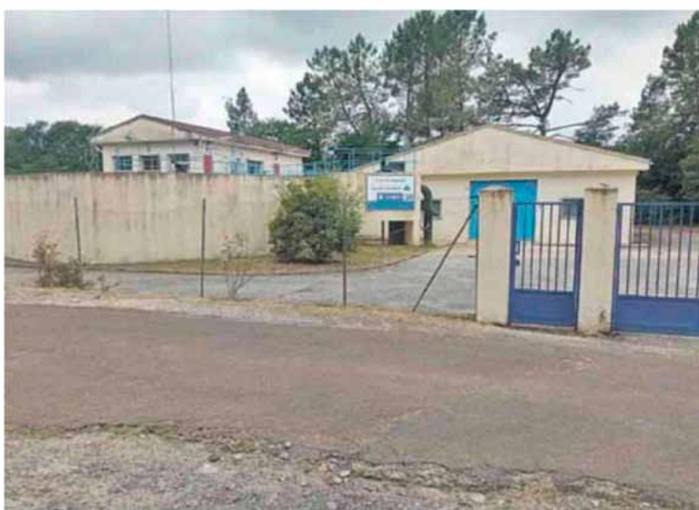
Instalaciones de la depuradora de agua para consumo humano en Carballiño.
