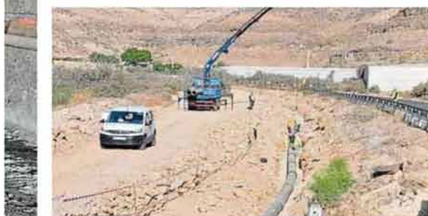
La colocación de la tubería de impulsión continúa avanzando. c7
