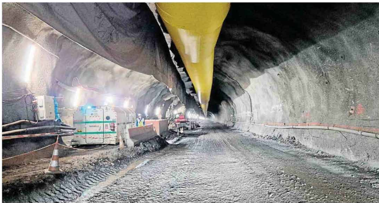
Imagen del túnel principal de la central hidroeléctrica reversible, del que ya se han excavado 1.800 de sus 2.160 metros de longitud desde la boca de entrada en Las Filipinas. c7
