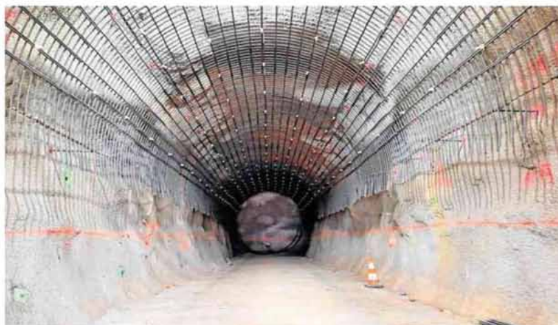
La excavación de la toma de agua en el cauce de la presa de Soria, parte del circuito hidráulico, está hecha. 67
