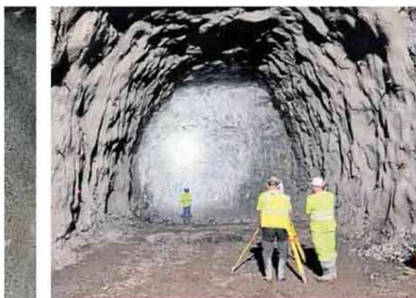
Trabajos de la galería piloto con la que se empieza a excavar la caverna. c7
