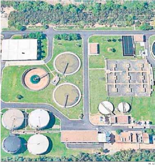
Vista aérea de la depuradora de San Jerónimo.
