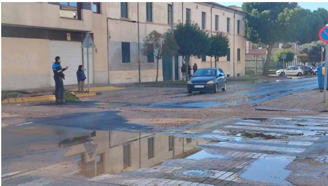
Reventón en la avenida de Lasalle
