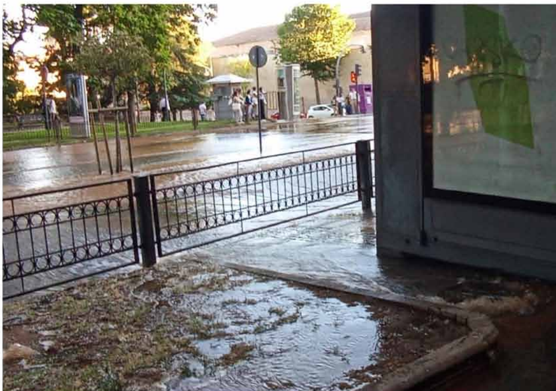
La rotura de otra tubería vieja inunda el paseo de San Vicente tras un potente reventón
